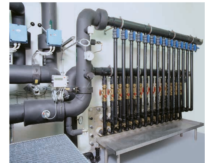
Erdwärmesondenverteiler
