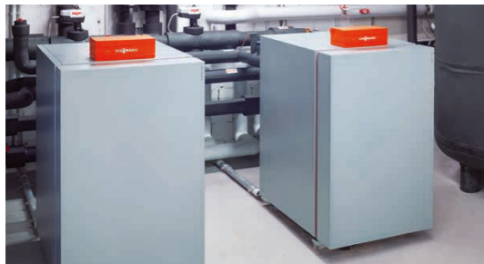
Die Sole/Wasser-Wärmepumpen Vitocal 300-G verfügen jeweils über eine Leistung von 12,6 kW.
