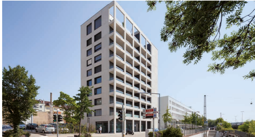
Das generalsanierte Wohnhochhaus in Pforzheim setzt zu hundert Prozent auf regenerative Energiequellen.
