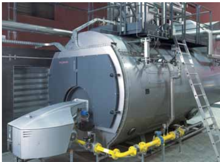
Der Economiser ECO sorgt für eine effiziente Nutzung der Restwärme von Abgasen.
