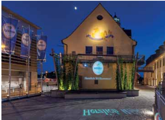
Deutliche Energiekostensenkung durch Modernisierung der Dampfkesselanlage
